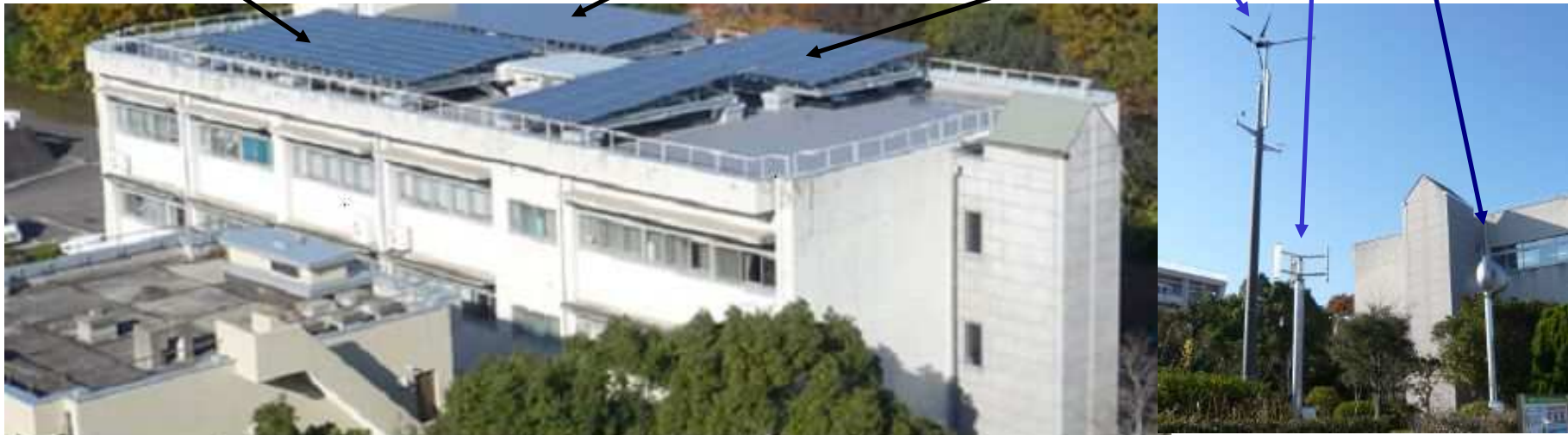
太陽光・風力複合発電システム
