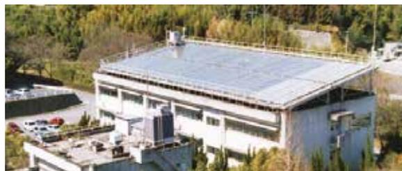
研究棟は太陽熱による冷暖房を行う事で、太陽熱集熱器を設置せねばなりません。そのため、広い屋上面積が必要ということで、通常は5階建である建物が3階建てになりました(写真 大型太陽熱集熱器を設置したエネルギー工学科研究棟)。また冷暖房負荷を下げるため、建物の壁には通常の倍の厚さの断熱材が入られ、窓は断熱ガラスが使われました。先年の大学の建物の耐震改修でも外壁の断熱の強化、断熱ガラスの使用による窓の断熱の強化が行われていますが、エネルギー工学科の建物はそれに先駆けるものでした。さらに断熱の強化はエネルギー消費量の削減だけではなく、そこに居住する者
